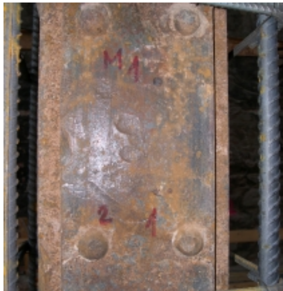
2. és 3. kép Mérési pont a pilléren, betonozás előtt, majd azt követően
