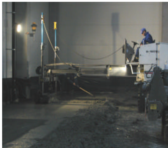
4. ábra: Laser Screed a felület simítása közben
