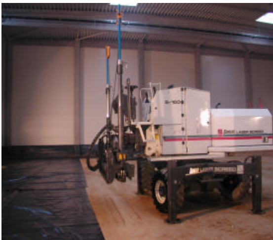
3. ábra: Laser Screed
