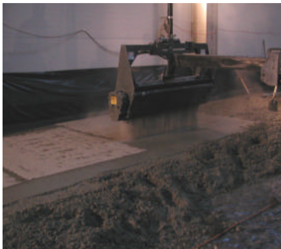
5. ábra: A kopóréteg felhordása por alakban közvetlenül a felület simítása után
